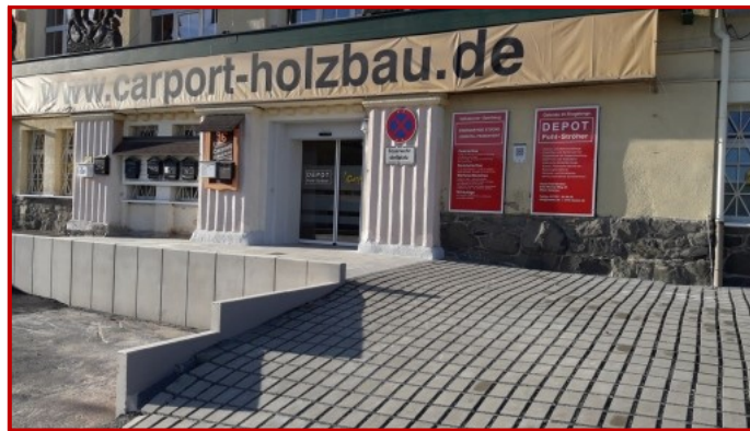
Neugestalteter Eingangsbereich am Gebäude | Foto: Michael Schuster
